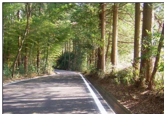
舗装された林道本戸前山線
