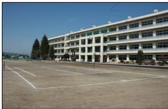
耐震補強された友部中学校
