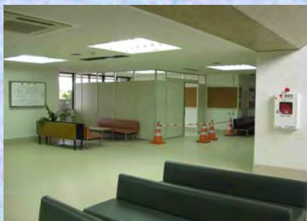
改修が進む市立病院
