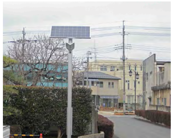
市立病院に設置したソーラーパネル及びソーラー式LED外灯
