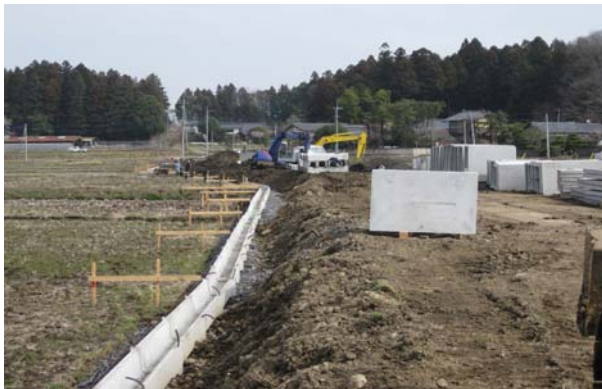
整備が進む1級12号線(矢野下地内)
